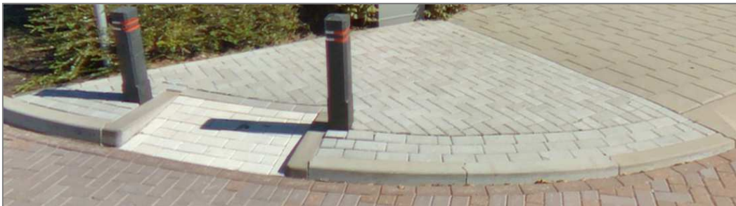
Verharding bij afronding trottoir met minder-valide oprit
